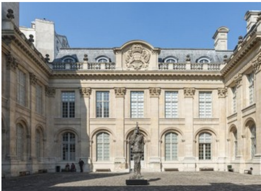
Illustration 2: Vue de la cour du mahJ Site du mahJ
