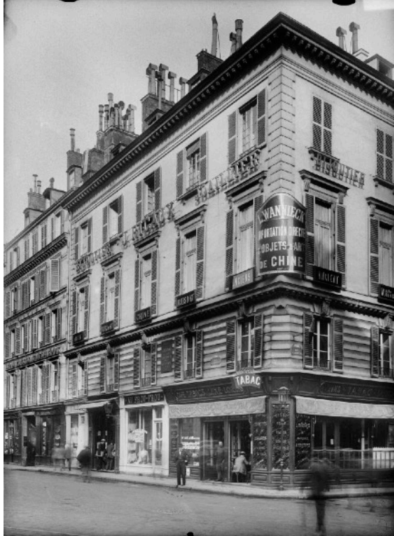
Fig. 90. Vue extérieure de la galerie au 1 rue Saint-Georges, à Paris.
