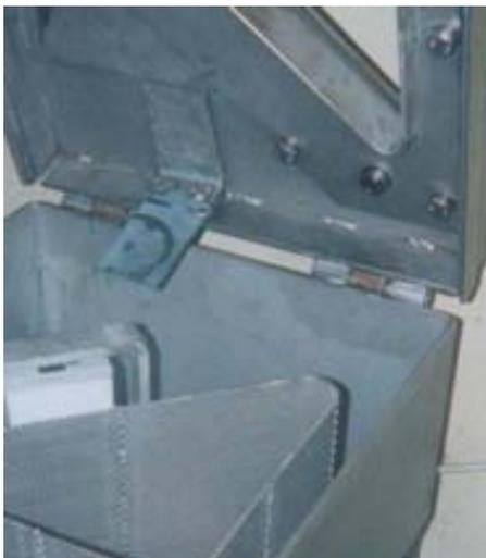
**Photo 19** : Exemple de distributeur d'aliments - Chaque matin, le soigneur place des aliments dans douze de ces boîtes d'acier qui sont installées dans le sol tout autour de l'île. Les couvercles sont fermés par des électro-aimants et ne peuvent seulement être ouverts par les gorilles que quand le système s'éteint (programmé de manière aléatoire par le soigneur) - Rotterdam Zoo [176]
