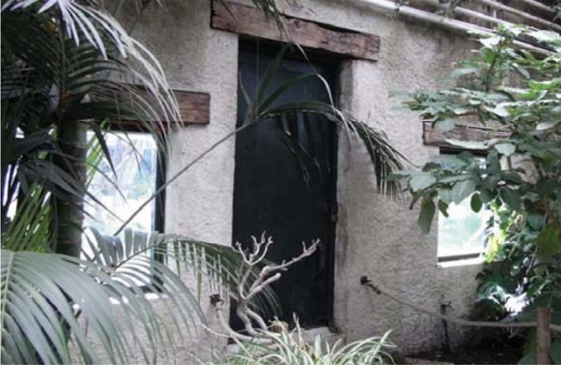
Photo 34 : Porte en acier galvanisé pleine, permettant un accès direct sur une île pour orang-outan. Remarquez la présence de grande fenêtre de part et d'autre de la porte permettant un contrôle visuel de l'ensemble de l'espace avant l'ouverture de la porte (ZooParc de Beauval) [Original]
