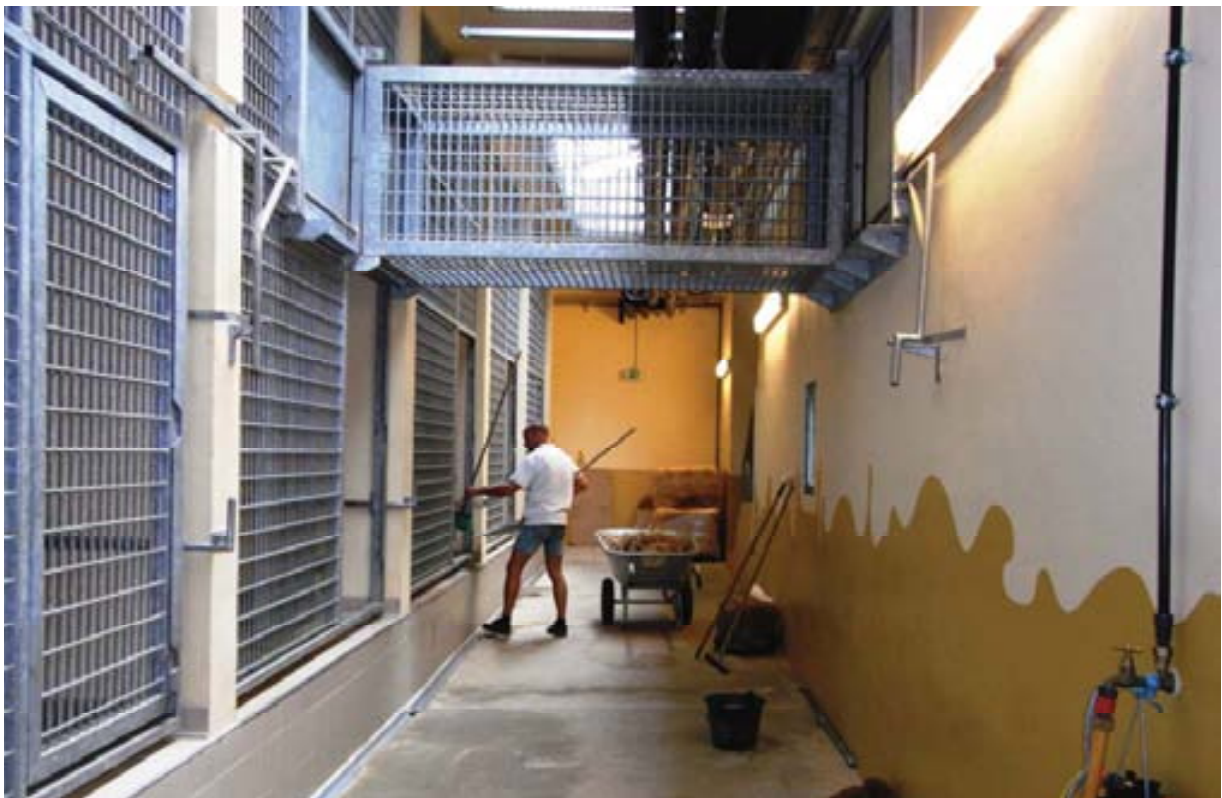
Photo 28 : Tunnel grillagé en acier galvanisé passant au-dessus du couloir d'entretien (Zoo de la Palmyre) [Original]
