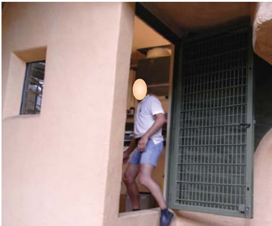
Photo 33 : Porte en acier galvanisé entièrement grillagée et sécurisée, permettant l'accès à la zone d'habitat d'un groupe de gorille. Remarquez la petite fenêtre sur le côté permettant un contrôle visuel de l'ensemble de l'espace avant l'ouverture de la porte (Zoo de la Palmyre) [Original]
