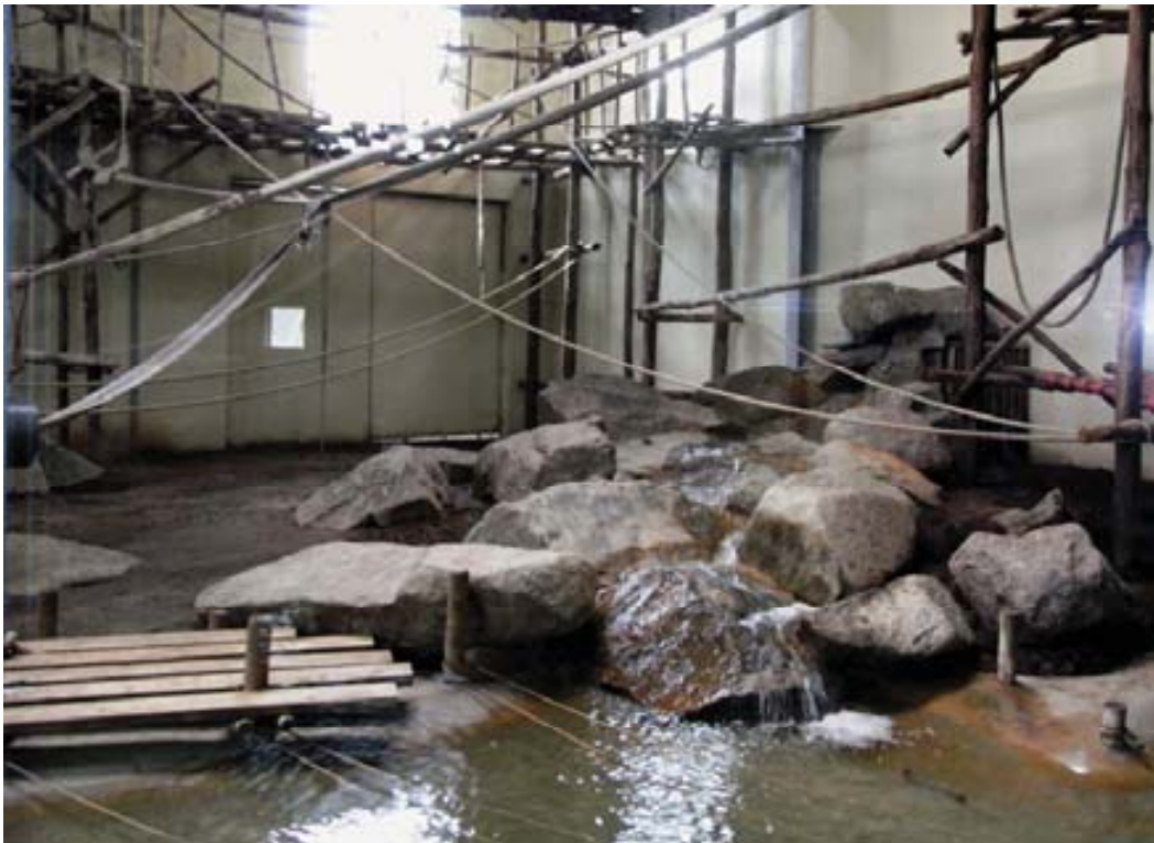
Photo 30 : Cascade intérieure se déversant dans un fossé d'eau dans un espace de vie d'orang-outan. Remarquez la grande double porte de service au fond du bâtiment (Zoo d'Annéville) [Original]
