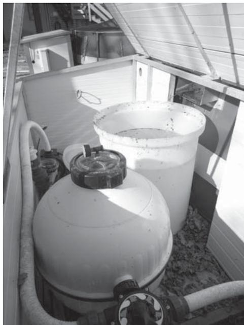
Photo 54 : Système de filtration des piscines
