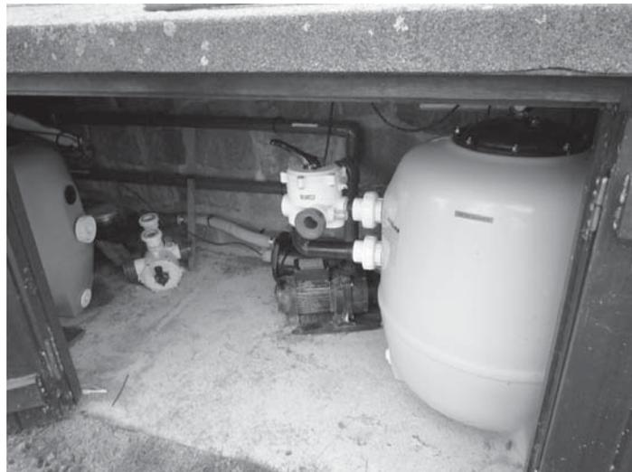
Photo 39 : Système de filtration de l'eau des piscines à la station LPO de l'île Grande
