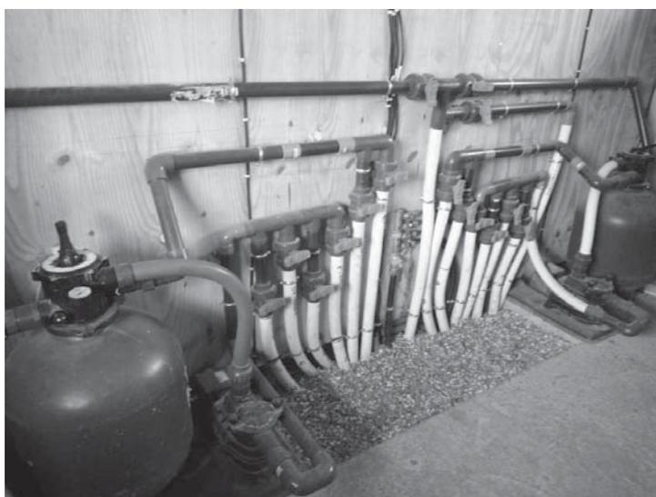
Photo 49 : Système de filtration des piscines au CHENE
