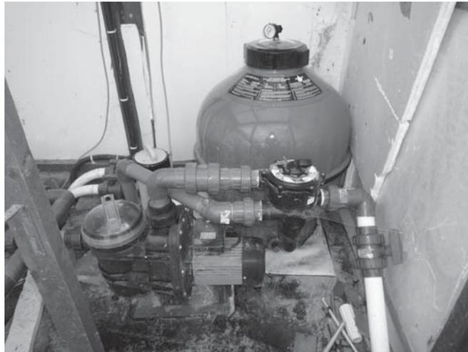
Photo 46 : Système de filtration des piscines au CVFSE ONIRIS
