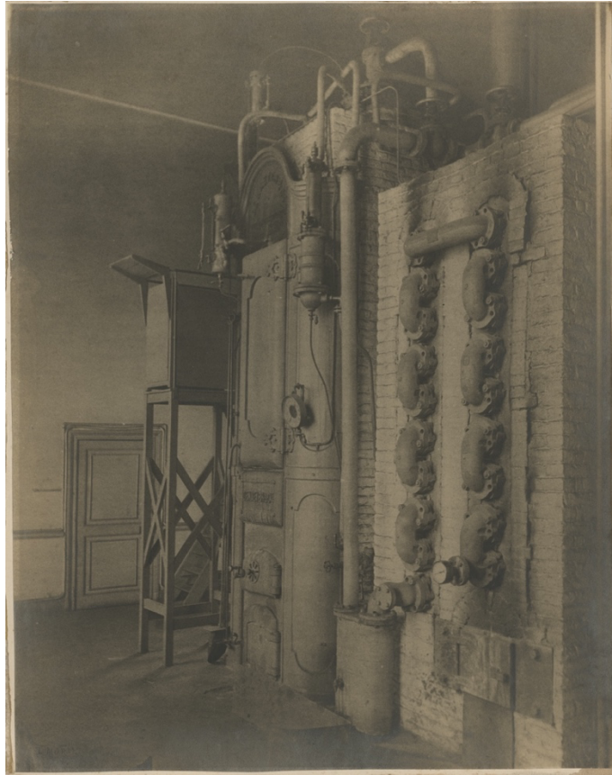
Figure 2-14 : Vue de la chaudière de la machine à vapeur. L. MORIN, Université de Liège - Faculté technique - Laboratoire de mécanique appliquée , Photographie, 35 x 45 cm, Musée Wittert ULiège, Numéro d'inventaire 43233, s.d. © Musée Wittert ULiège
