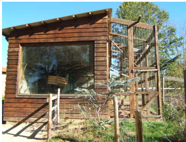
Figure 9 : le bâtiment et la volière des Patas.
