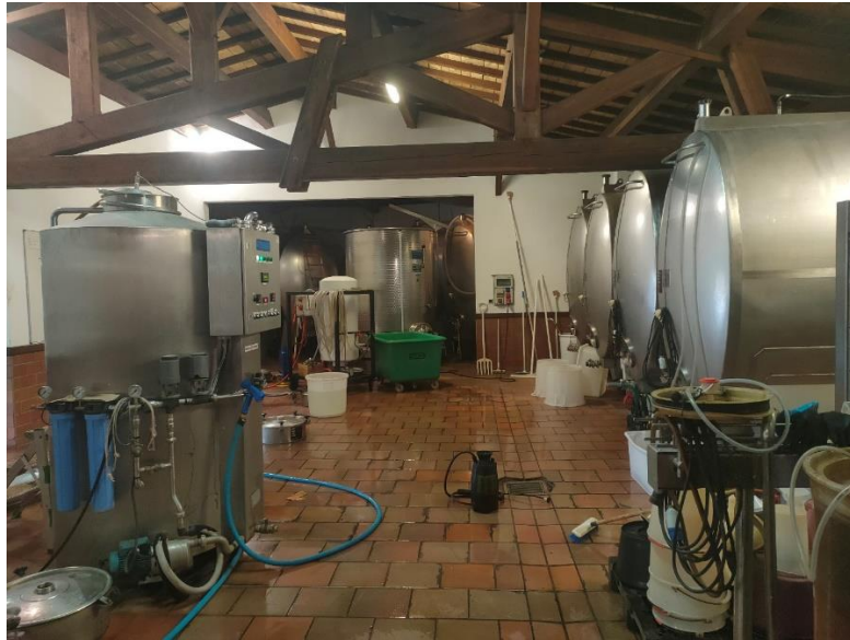
Figure 14 : Vue d'ensemble de la première cuverie
