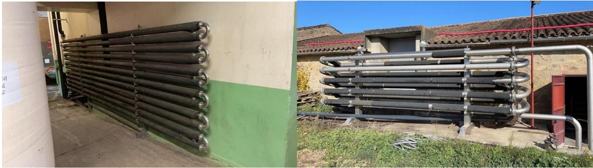
Figure 9 Photographies de l'échangeur à mout (à gauche) et de l'échangeur à vendange (à droite)(source : interne)
