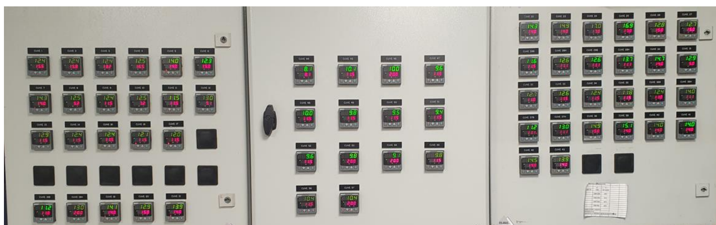
Figure 21 : Console de gestion des températures du cuvier
