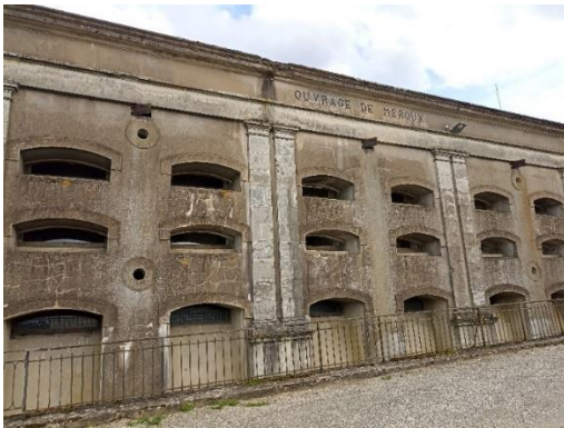
Ouvrage de Meroux 41
