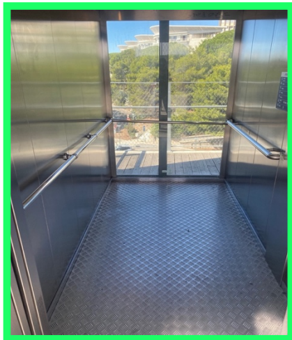
Figure 11 : intérieur de l'ascenseur extérieur
