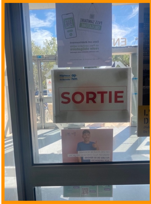
Figure 58 : pancarte signalétique de sortie peu visible en contre jour
