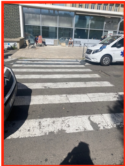
Figure 15.bis : passage piéton non signalé
