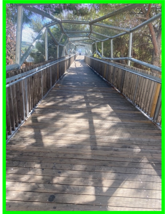
Figure 15 : chemin menant à l'entrée du CHU, sécurisé par des grillages
