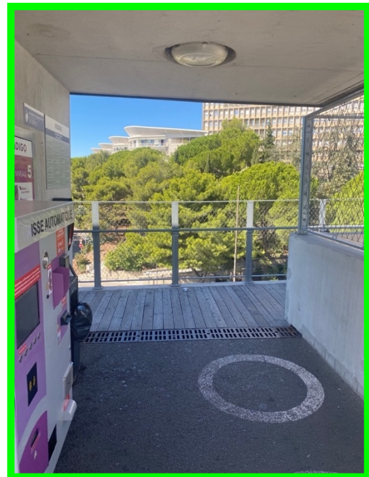
Figure 13 : balises au sol à la sortie de l'ascenseur extérieur
