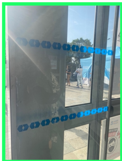
Figure 17 : portes vitrées automatiques de l'entrée avec lignes de contraste
