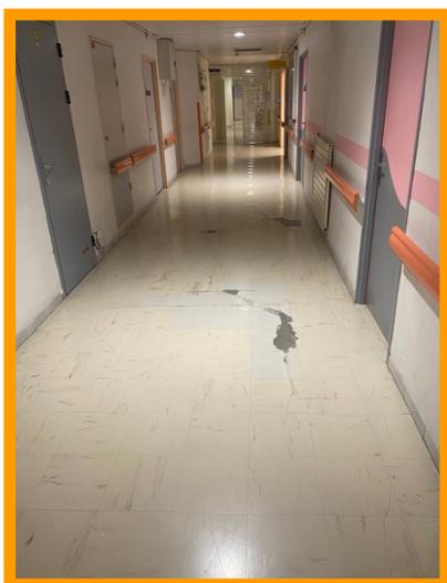
**Figure 33 :** Le couloir présente des mains courantes auxquelles s'appuyer, aucun guidage podotactile n'est présent jusqu'à l'accueil. De plus l'éclairage ne présente aucune homogénéité, avec une alternance de zones sombres et éclairées.
