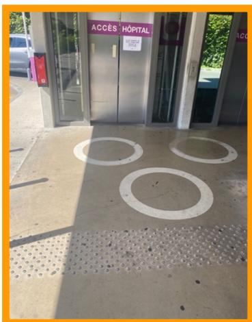
**Figure 10 :** Une bande podotactile signale le passage piéton menant à l'ascenseur, et des balises blanches en forme de rond tracées au sol permettent un repérage facile et rapide.
