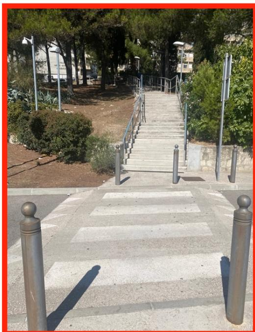
*Figure 4 : poteaux de signalisation non contrastés, passage piéton non signalé*
