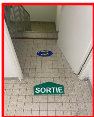
**Figure 44 :** escalier de sortie non signalés
