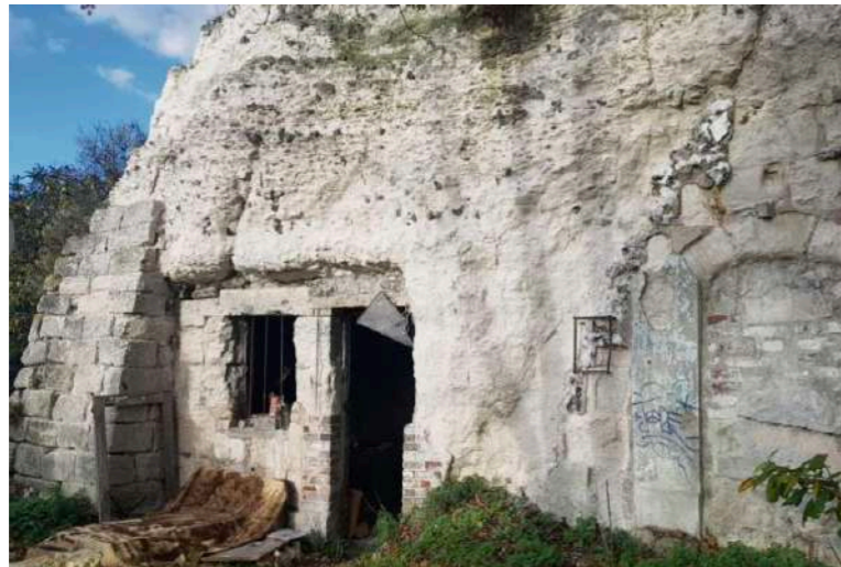
L'entrée vers les salles de vie creusées dans la falaise, on distingue aussi l'un des contreforts en pierre sèche à gauche 2
