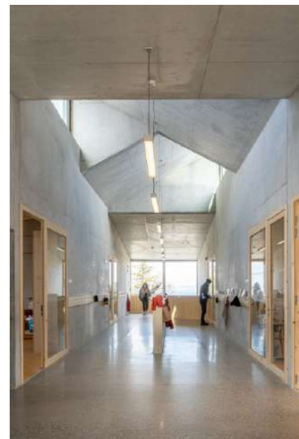
Le couloir de l'école élémentaire, éclairé par des canons à lumière
