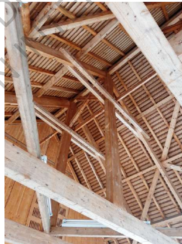
La charpente des bâtiments du projet, apparente 2
