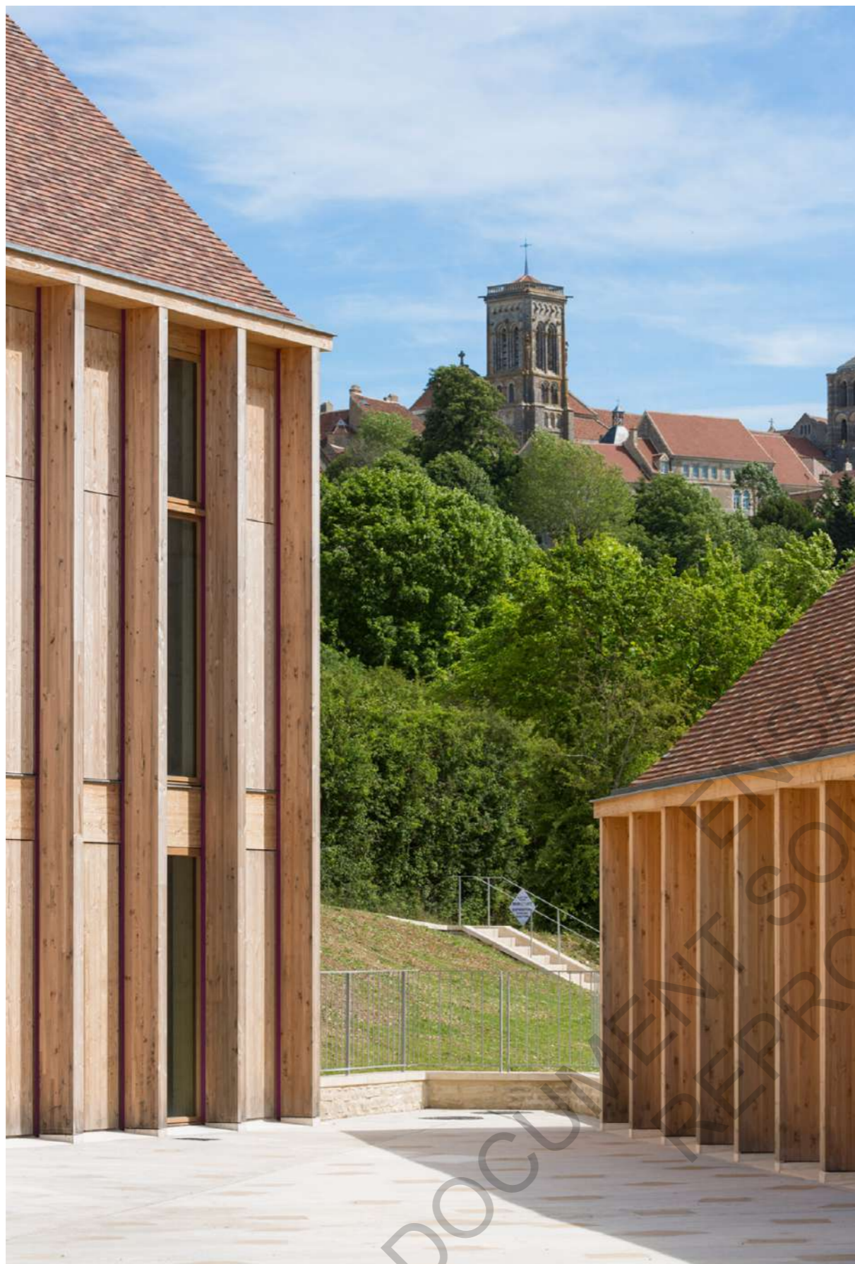
La proximité et les vues du Centre de Santé avec le village et sa basilique (Photo de Luc Boegly)
