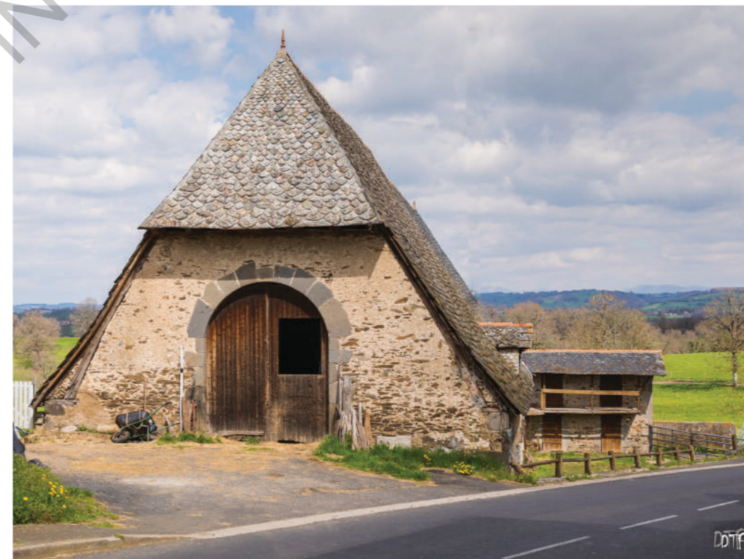
Une grange-étable vue depuis la route : sa façade est uniquement constituée du mur pignon 1
