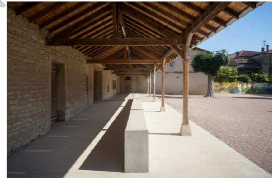
L'école vue de l'extérieur : hormis le décalage de toiture, le volume est simple 1 L'ancien préau adossé à l'un des murs de l'école 2
