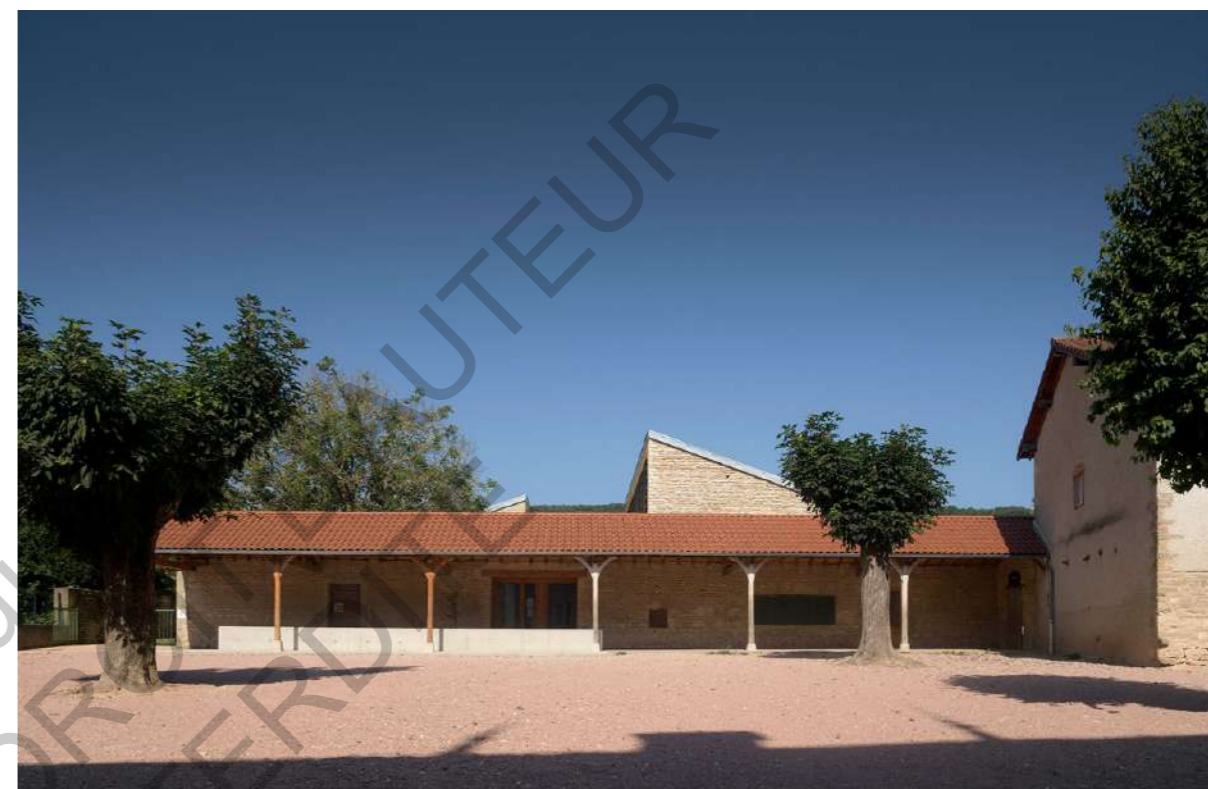
Le préau de la cour de l'école, charpente traditionnelle apparente, tuiles, pierres locales 1
