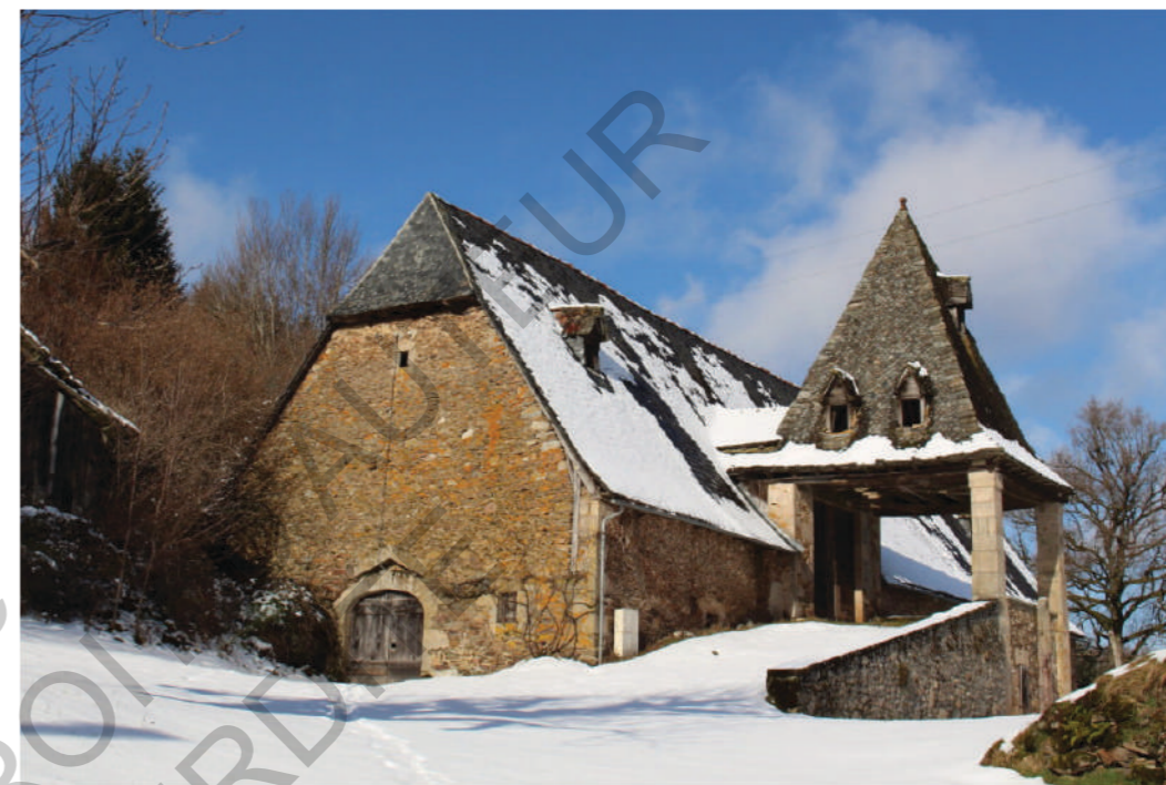
Une grange-étable vue depuis sa parcelle : à droite la montade qui mène à un accès latéral 1
