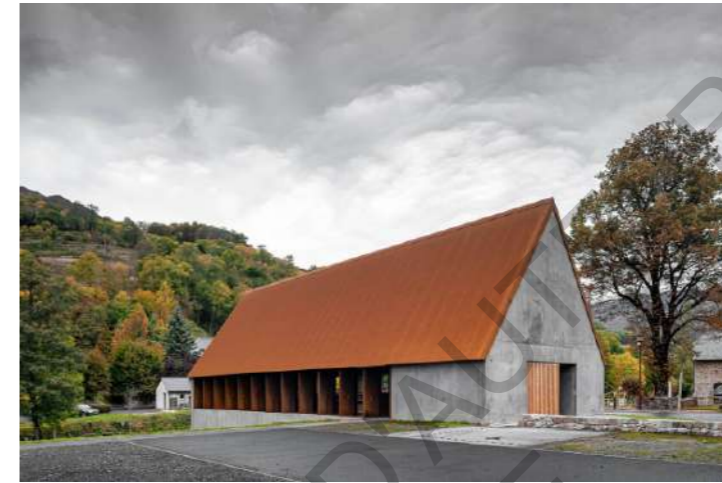
La Halle vue depuis l'accès à la parcelle : la pente est telle que la halle semble être à plusieurs niveaux, et émerger du sol 1
