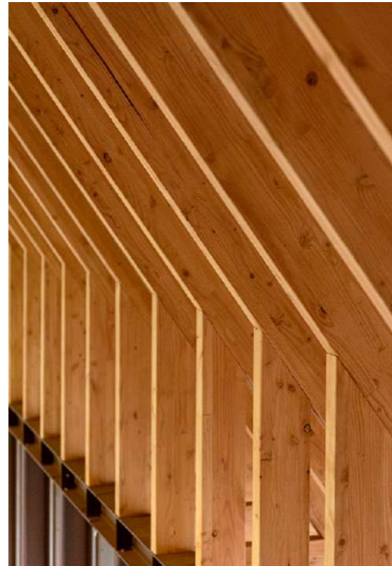
La charpente en douglas 2
