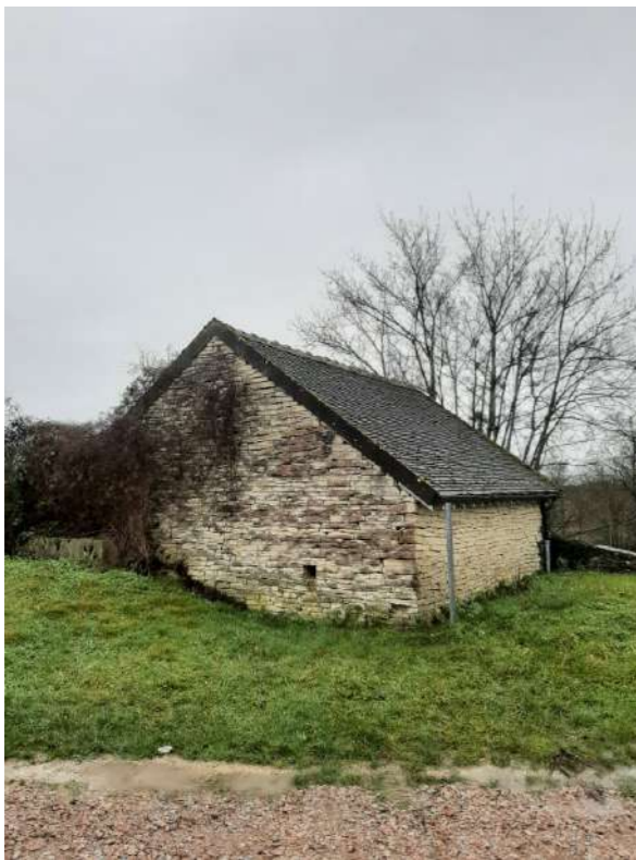
Un bâtiment existant au Sud du parking 1
