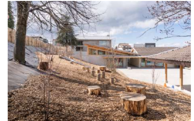
Le talus de la cour de maternelle
