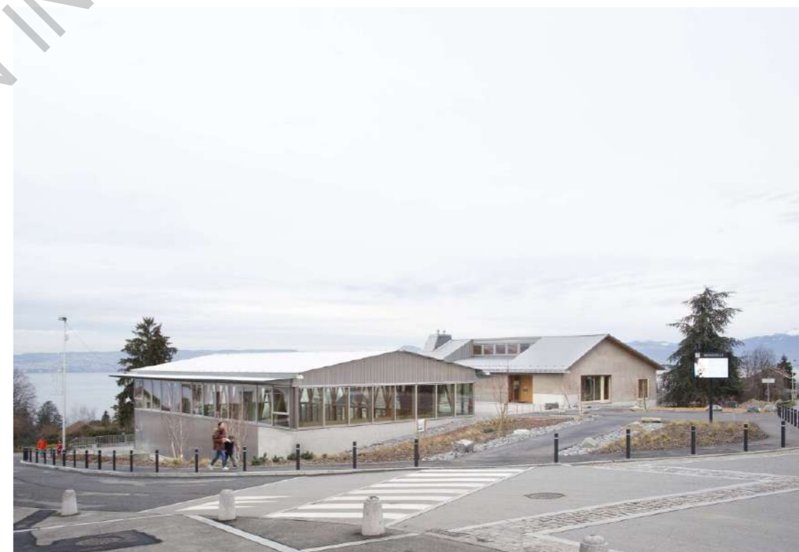
Le gymnase et la médiathèque vus depuis la rue (au Sud-Ouest de la parcelle) 2
