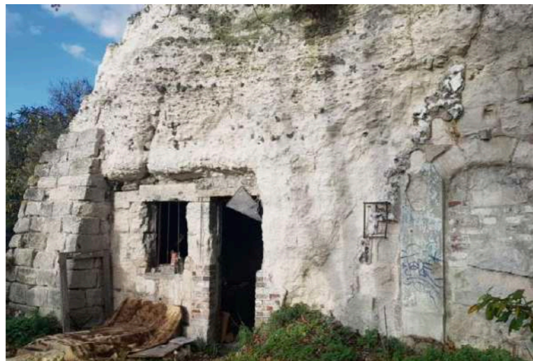
L'entrée vers les salles de vie creusées dans la falaise, on distingue aussi l'un des contreforts en pierre sèche à gauche 2
