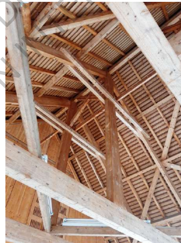
La charpente des bâtiments du projet, apparente 2
