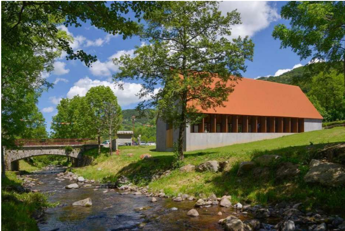
La Halle de Mandailles-Saint-Julien vue de profil, en tension avec la pente existante 1
