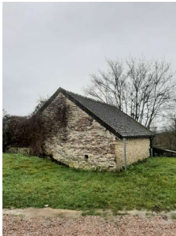
Un bâtiment existant au Sud du parking 1
