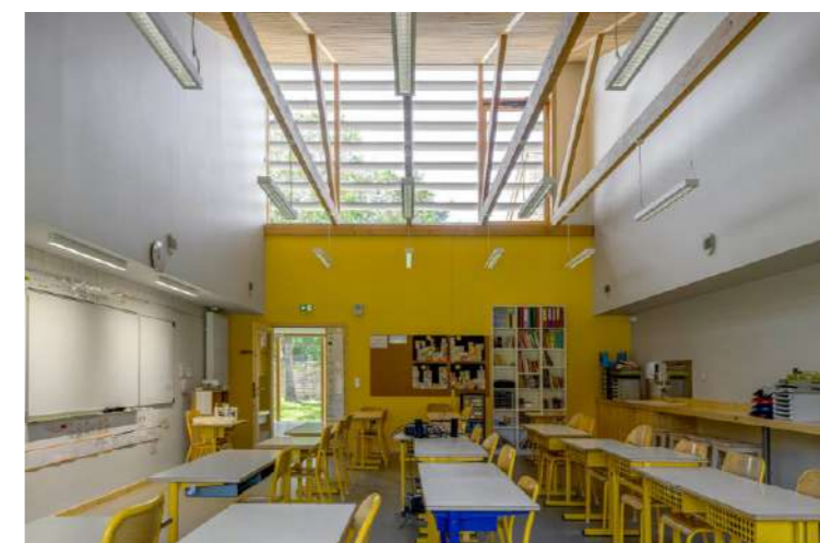
Une salle de classe, qui bénéficie d'un éclairage en hauteur grâce au découpage des toitures
