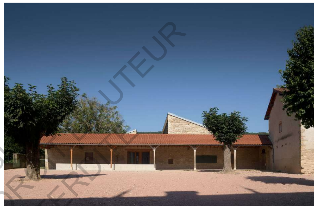
Le préau de la cour de l'école, charpente traditionnelle apparente, tuiles, pierres locales 1
