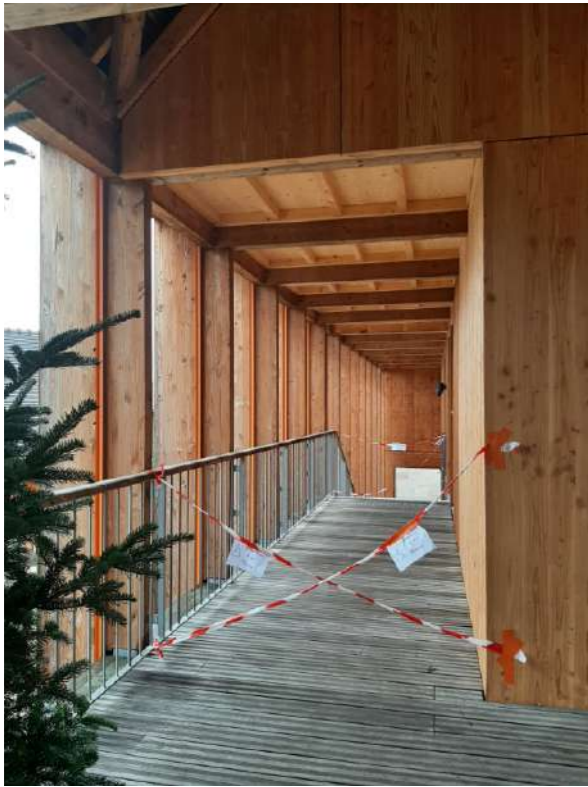
Vue en haut de l'escalier 1
