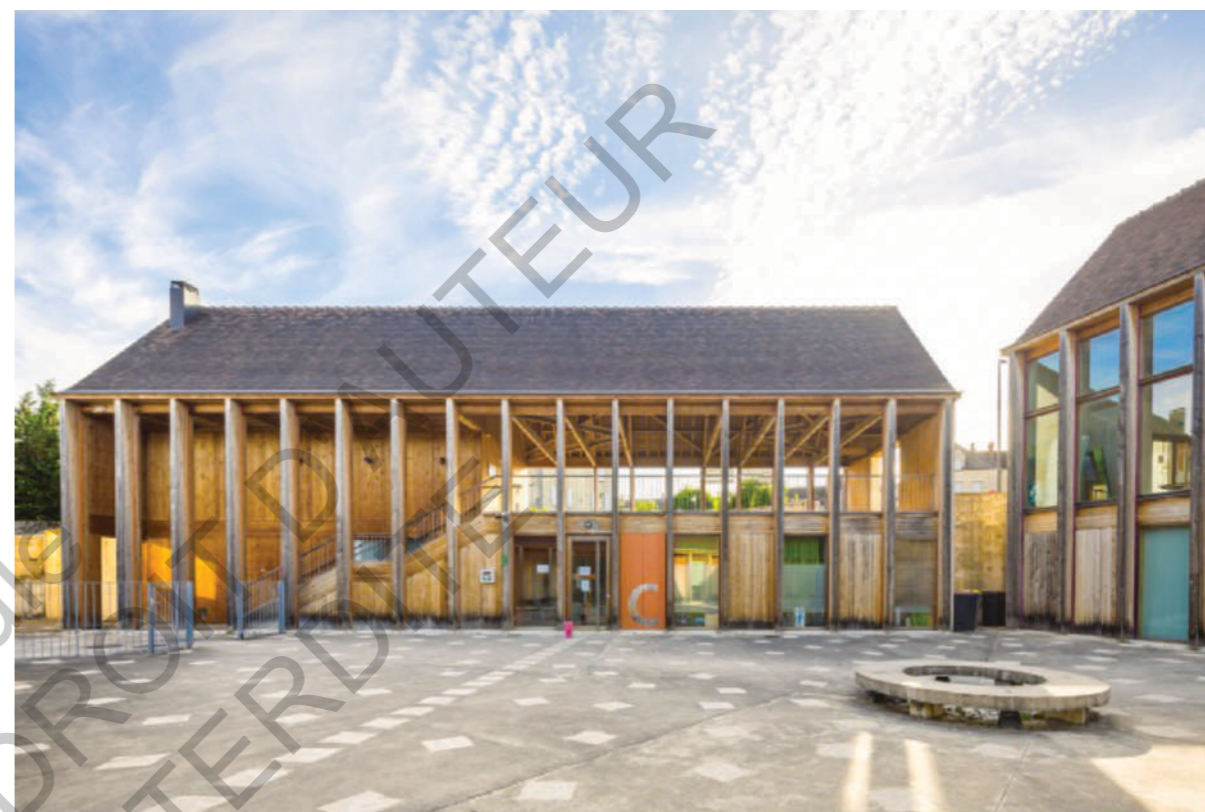
La cour, au centre de l'ensemble des bâtiments 1
