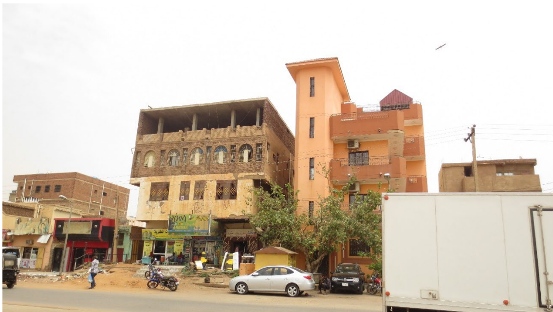
Figure 7. Nouveaux immeubles dans le quartier de Deim, (Parot, 2021).
