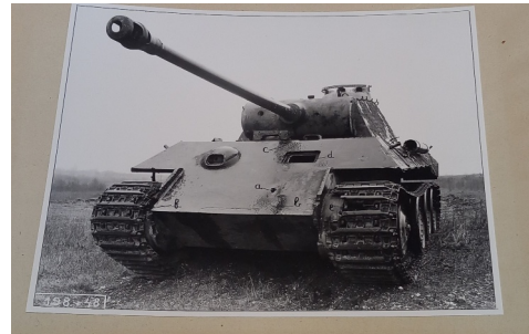
Etat du matériel après tir en a Impact d'une charge creuse (P.V. N° 2) Les impacts en b-c-d (le volet a été arraché) e-f ont été obtenus aux tirs faisant l'objet du présent P.V.
