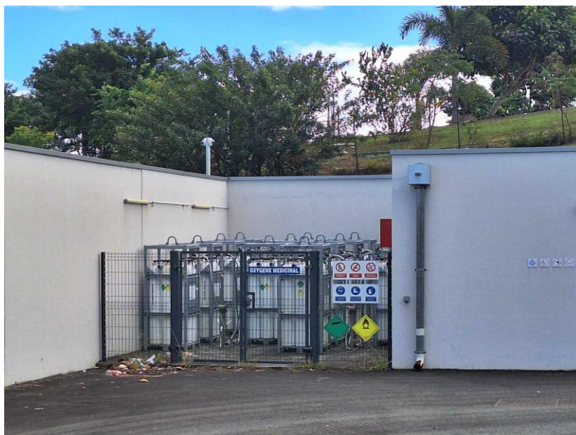
Figure 13: Réserve d'oxygène à usage médical du CHT, Juillet 2023
