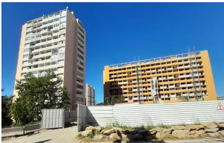
Photo 10 Bâtiment A préparé pour la démolition qui commencera en juin 2024 (photo personnelle, 2024)
