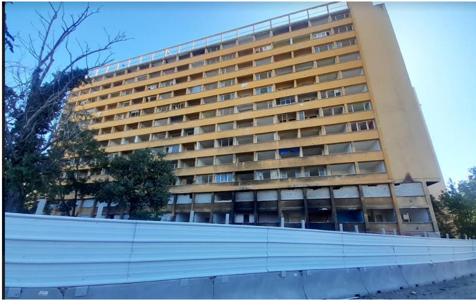
Photo 11 Bâtiment A préparé pour la démolition qui commencera en juin 2024 (photo personnelle, 2024)
