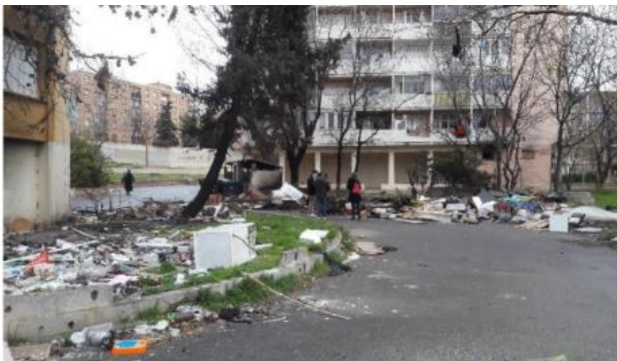
Photo 5 Les abords du bâtiment A (diagnostic technique Citémétrie, 2018)
