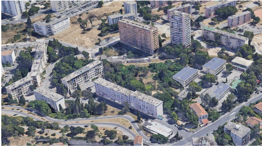
Photo 2 Photo aérienne de la copropriété (Google Maps, 2024).
