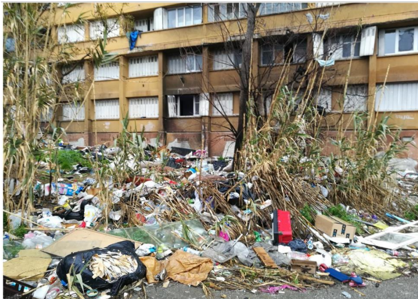
Photo 4 Les abords du bâtiment A jonchés de déchets (diagnostic technique Citémétrie, 2018)
