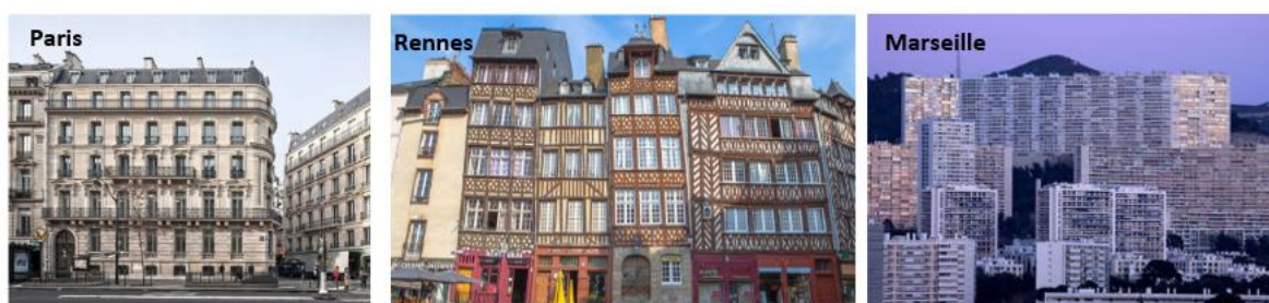
Photo 1 Des copropriétés aux formes urbaines bien variables. (Google Maps, 2024)
