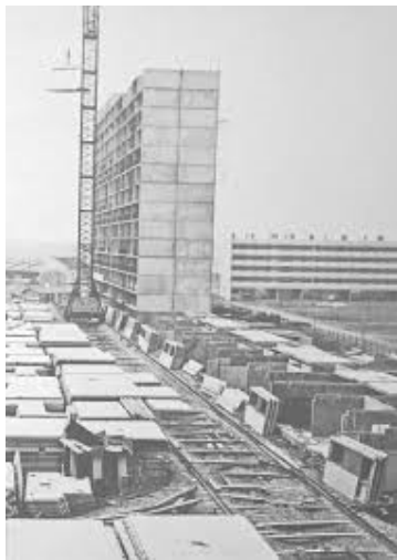
3. Auteur non identifié, La Cité des 4000 en chantier à La Courneuve, 17 mars 1965, détail du chemin de grue sur le cliché inv. S6 n°17 des archives municipales de La Courneuve
