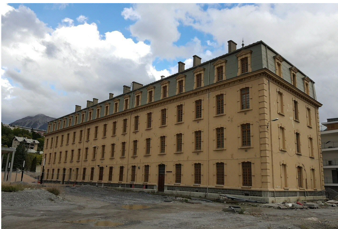
Figure 37 : un des bâtiments de la caserne Berwick, qui sera conservé et réhabilité (J. Mourez, 2019)
