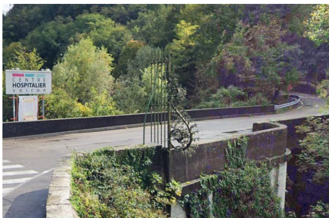
Figure 50 : élément de la grille de l'accès par le pont sur la Morge (Google Maps, 2019)
