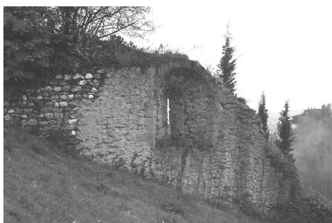
Figure 47 : fragment du mur d'enceinte (J.-P. Moyne, 1980)
