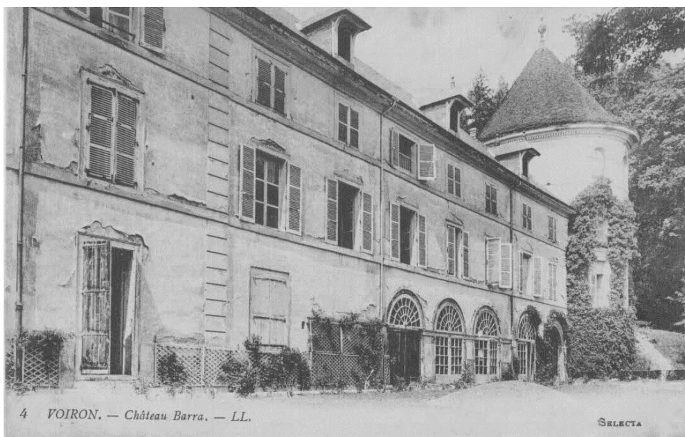
Figure 49 : l'orangerie (façade sud-est) et la tour de la Chapelle (Histoire et patrimoine du Pays voironnais, s.d.)
