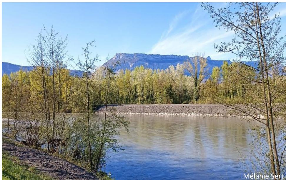
Photographie d'une digue au 2 avril 2024 qui vient de subir des travaux de renforcement par enrochement. La digue est désormais « à nue ».
