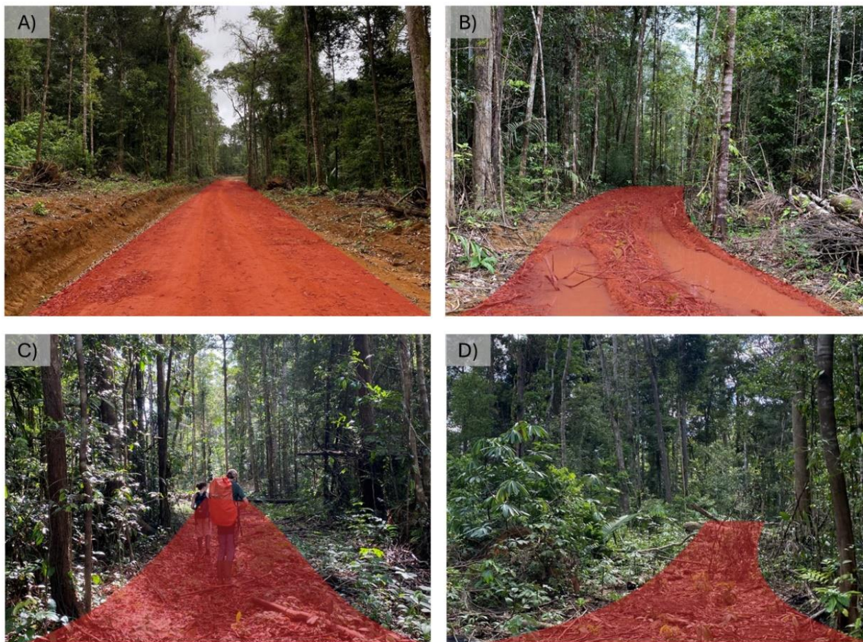
Figure 5) Assemblage de photos illustrant la morphologie des différents types de routes et de pistes du réseau de la desserte forestière. Les zones rouges permettent de mieux visualiser les zones de roulement. A) Piste à camions ; B) et C) Pistes principales ; D) Pistes secondaires
