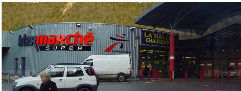
Le centre commercial La Vallée (source : www.leprogres.fr/jura/2011/12/02 )
