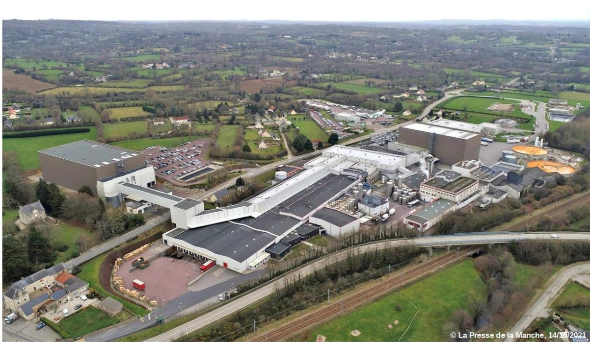
Figure 30: L'usine de Sottevast des Maitres Laitiers du Cotentin
