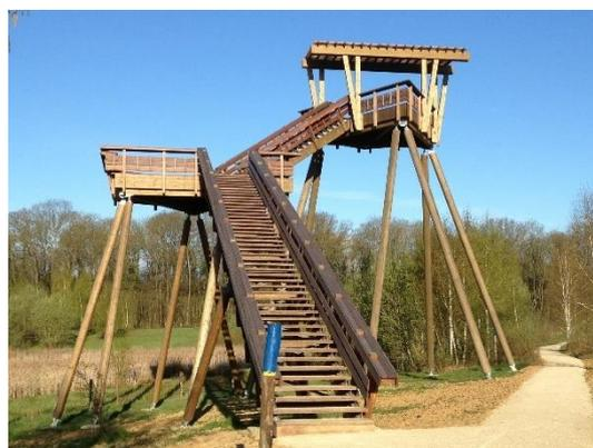
*Figure 29 : Belvédère à Bois d'Arcy (78), 12 mètres de haut, projet par Coulon Leblanc et ouvrage par SLE*
