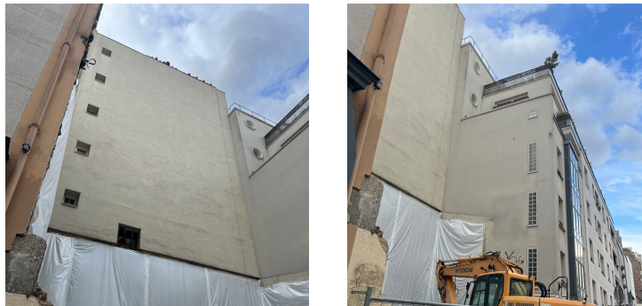
Figure 46 : Photographies d'héberges avec en fond de parcelle des jours (à gauche) et des pavés translucides (à droite) à Paris 20e
