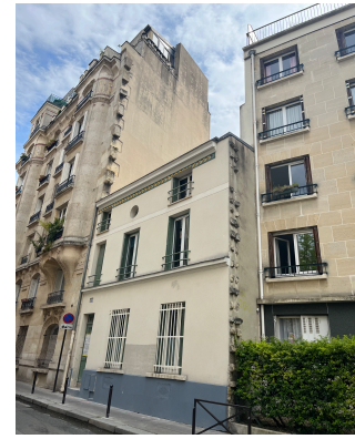
Figure 27 : Photographie de deux types de harpes d'attentes de mitoyenneté à Paris 20e
