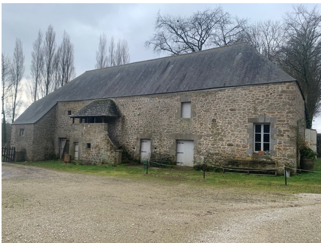
Figure 1 – Premier manoir, édifié en 1637, actuelle boutique (fenêtre droite), cour des dépendances, 23 février 2023, (© Théo Lizard-Perier)
