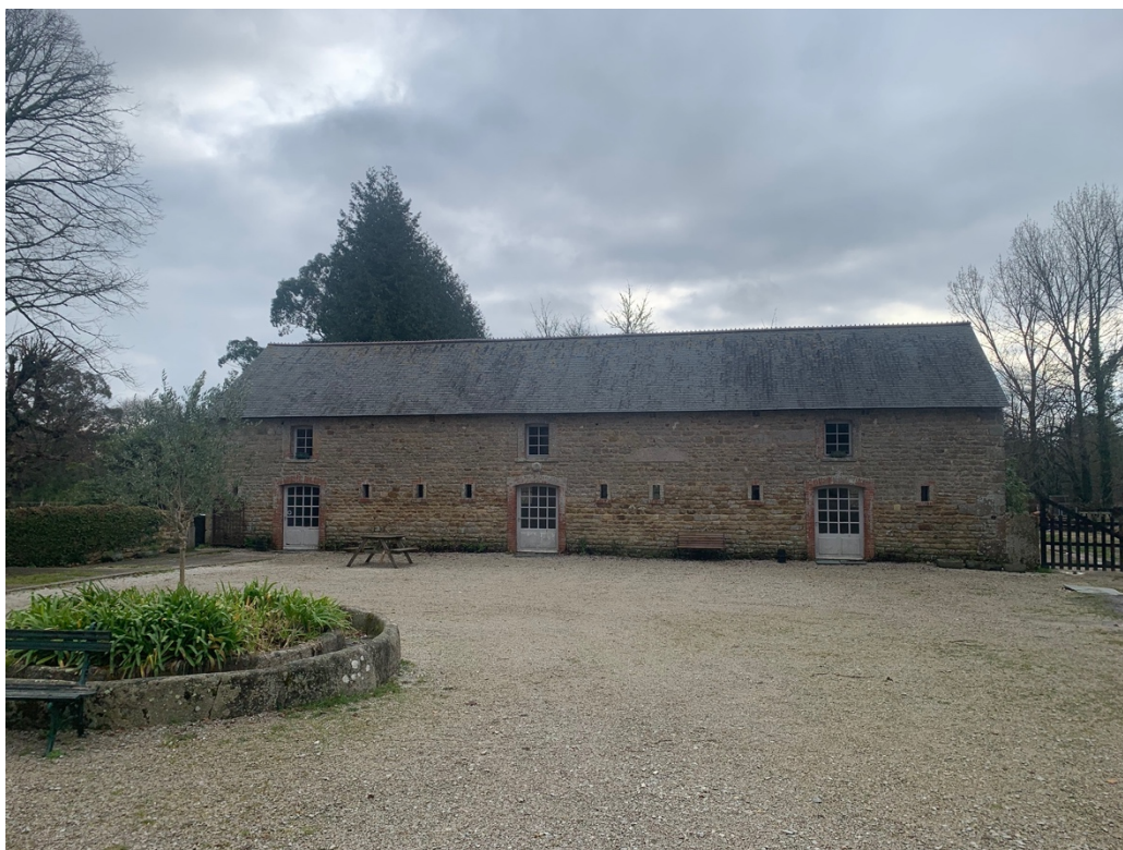
Figure 7 – Salle du canal, édifée en 1895, servant de salle de réception (mariage, séminaire, événements, etc), située à gauche du premier manoir, cour des dépendances, 23 février 2023, (© Théo Lizard-Perier )
