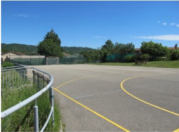
Le terrain de sport est intégralement en enrobé et bordé de pelouse.
