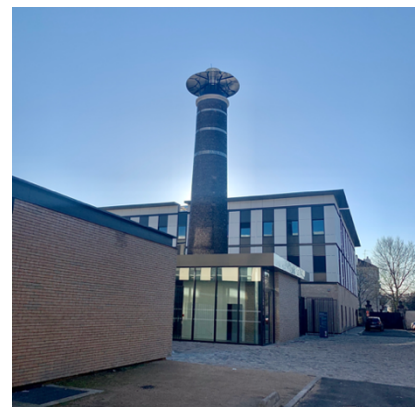
FIGURE 16. Photographie extérieure du bâtiment Nocard après rénovation (Photographie personnelle, janvier 2020)
