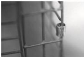
Clips en zinc mis en place
