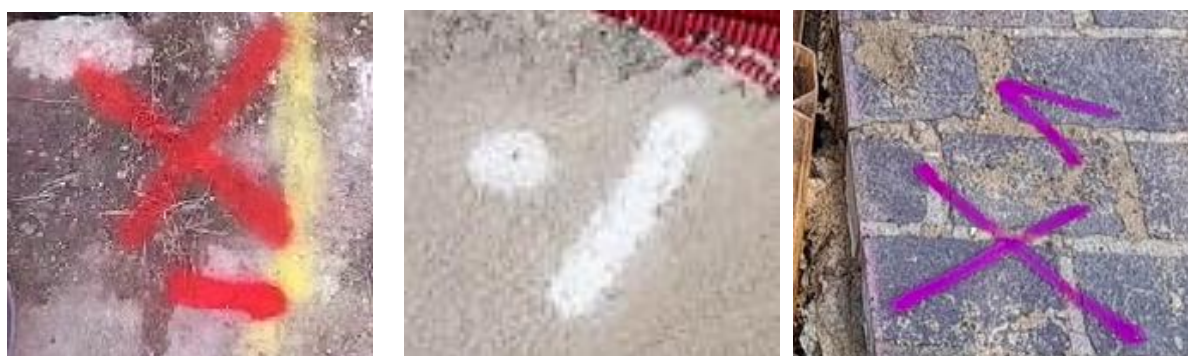
Figure 5 - Matérialisation à la bombe de peinture de points de calage. Source : Syslor, chantier n° 24XXXXX09471, 24XXXXX10379, 24XXXXX10318 (de gauche à droite)
