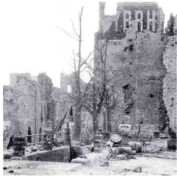
Entrée de l'abri côté Place Sadi Carnot
