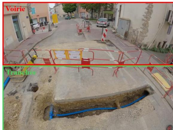
Figure 8 - Exemple d'image acceptable pour un levé de récolement avec une méthode de photogrammétrie terrestre.
