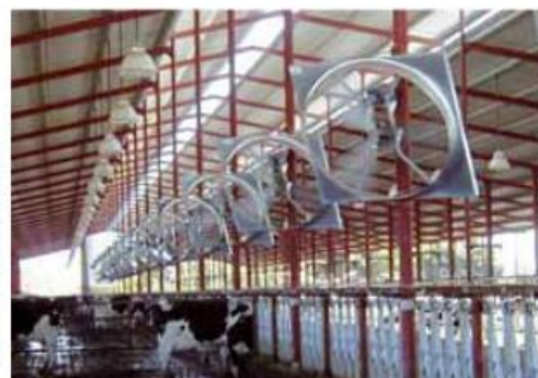
Figure 61 : Exemples de méthodes de rafraîchissement des bovins (à gauche : sprinklers, à droite : ventilateurs)
