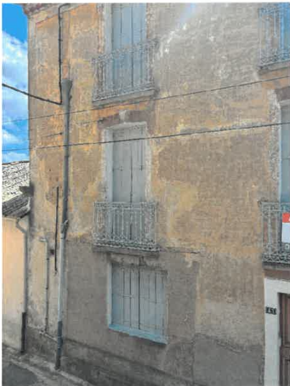
Ci-contre la photo de la maison « Maynau » correspondant à la parcelle F142 (Photo prise en juin 2024)
