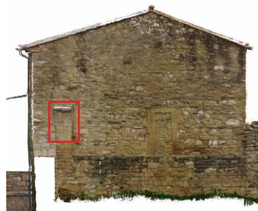
Figure 17: Façade ouest du logis prioral
