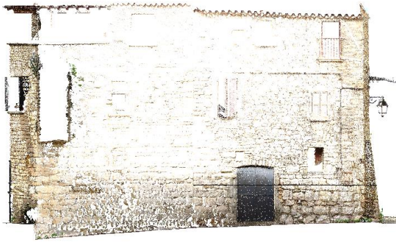
Figure 10: Nuage de points de la façade à l'angle de la rue des remparts avec une perte de détail due à une luminosité importante
