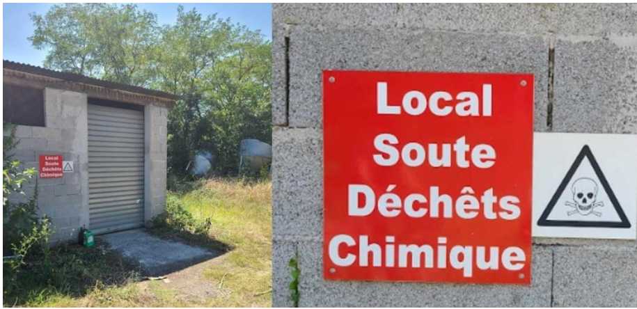
Figure 53 : Vue extérieure de la soute à DRCT et signalétique obligatoire
