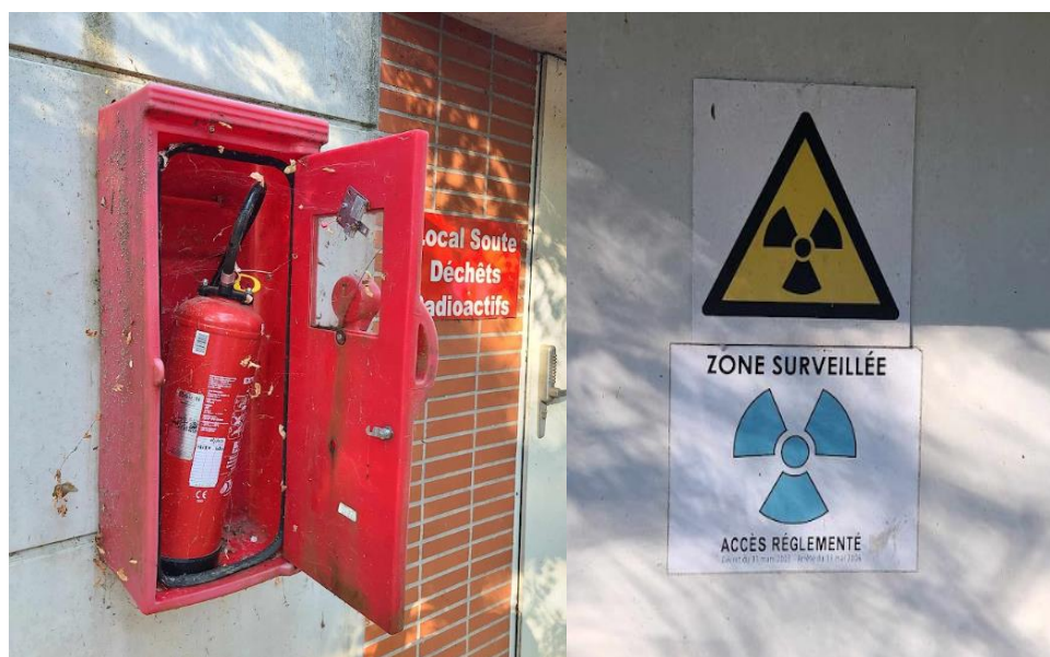
Figure 57 : Signalétique de la soute pour les déchets à risque radioactifs et extincteur
