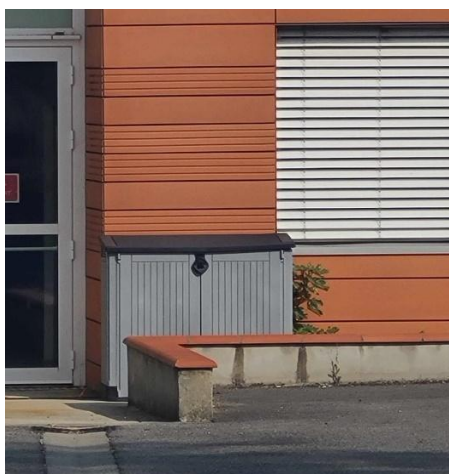
Figure 60 : Point de collecte A
