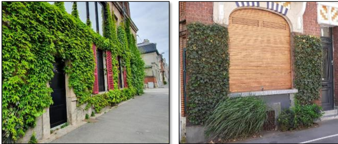
Figure 166: Photos de deux exemples de façades végétales à Lille - Source : (Ville de Lille, 2024)
