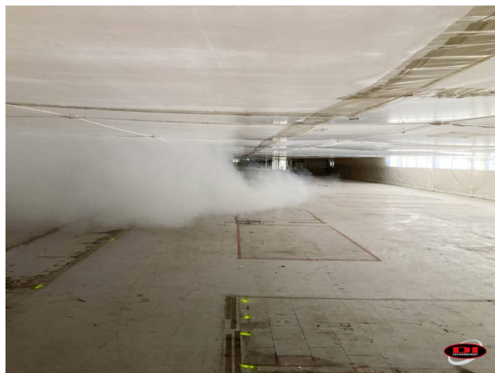
Figure 161: Test à la fumée effectué lors de travaux de vérification avant le désamiantage d'un bâtiment - Source : (DI Environnement, 2024)
