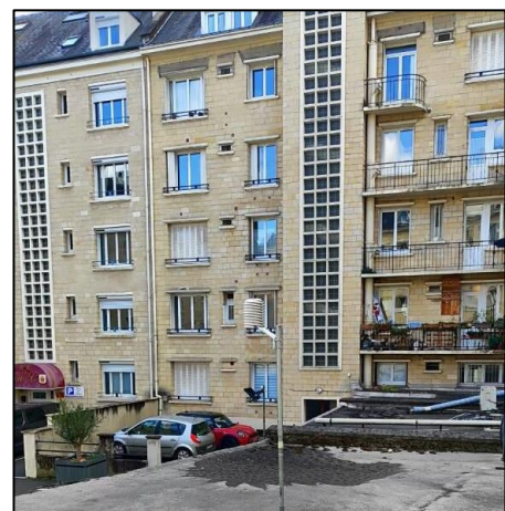
Figure 14: Photo de la station météo installée dans l'îlot de bâtiment permettant d'affirmer une surchauffe à l'intérieur de la cour - Source : O. Cantat
