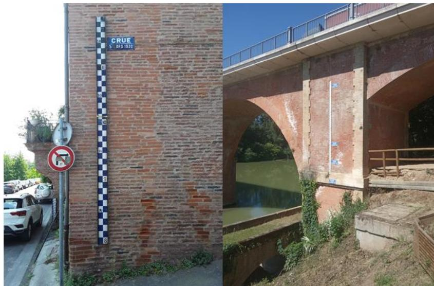
Figure 20 : Repères de crues associés à des échelles limnimétriques sur les communes de Montauban (à gauche) et Reyniès (à droite) (© Paul Desthomas, 2024)
