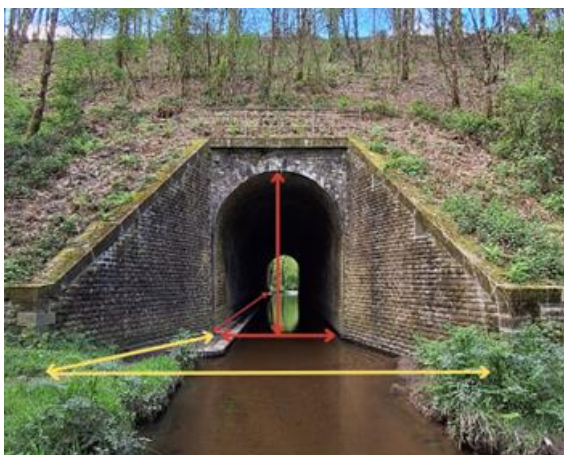
Figure 6 : Mesures réalisées sur les ouvrages d'art (exemple de l'ouvrage 75292) (source personnelle)
