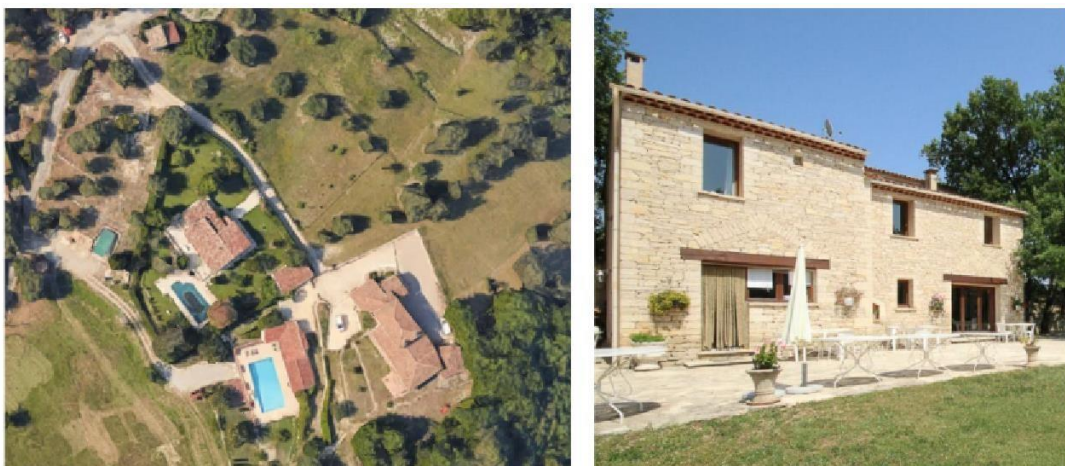
Figure 52 : Ancien corps de ferme transformé en gîte, 2024.
