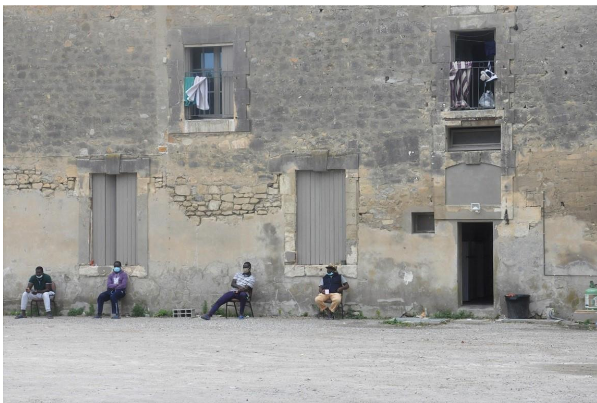
Figure 77 : Mas servant de logement aux travailleurs Terra Fecundis dans le Pays d'Arles - Source : Reporterre
