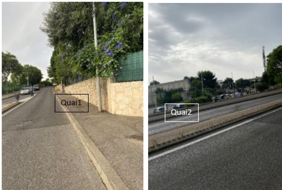
Figure 47 : Photos de 2 futurs arrêts de bus sur le Chemin du Puit de Brunet à La Ciotat, ITA nécessaire en réseau de la pente. Source : I. Mazioua, juin 2023.
