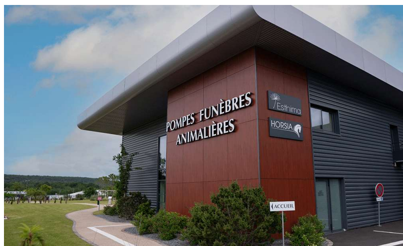
Figure 113 : crématorium Esthima de l'Etampes, Essonne
