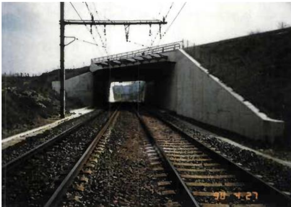
Figure 7 : Exemple de portique biais [2]
