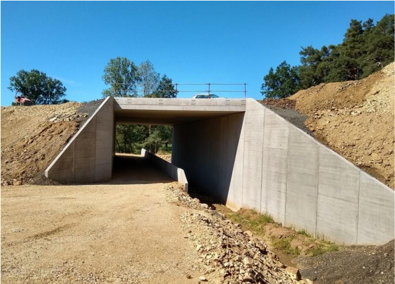
Figure 4 : Exemple d'un PICF exécuté par ARCADIS
