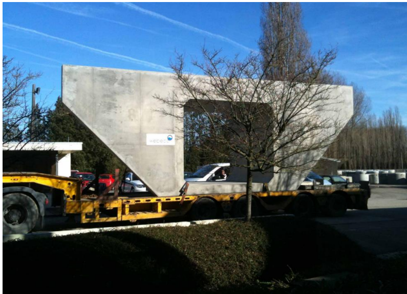
Figure 6 : Transport d'un cadre par camion [10]
