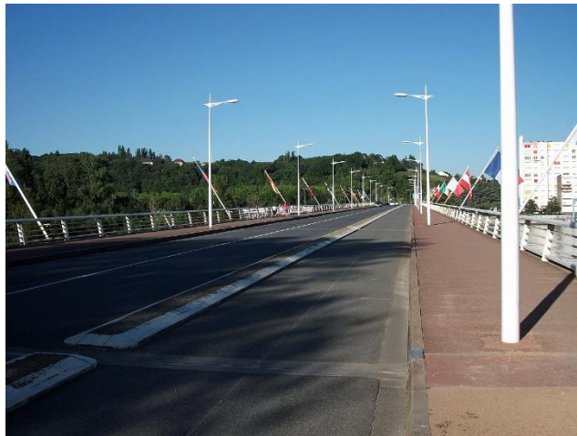
Figure 10 : Exemple de Superstructures sur la chaussée du pont de l'Europe (Garde-corps, trottoirs ou candélabre)
