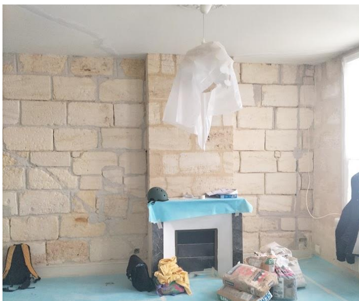
Figure 3 : Mur en pierres bordelaises en phase de rénovation sur un chantier Little Worker Source : Production personnelle
