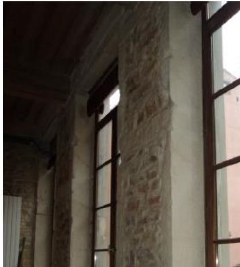
Figure 26 : Mur de façade avec pierre de Couzon apparente à l'intérieur d'un logement [33]
