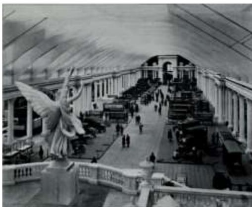
Figure 12 : Fermes en lamellé d'un hall à l'exposition universelle de Bruxelles (1910). (source : valentine)
