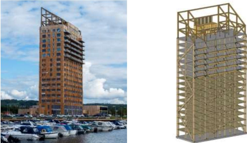
Figure 15 : Contreventement par diagonales en façade dans Mjøstårnet, Norvège, (2019).
