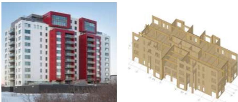
Figure 14 : Contreventement par voiles CLT dans *Origine*, Québec (2017). (sources :Stéphane Groleau, Nordic Structures)
