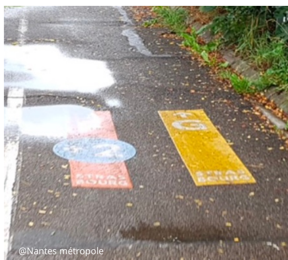
Figure 24. Exemple de marquage non visible à cause d'une voirie en mauvais état.
